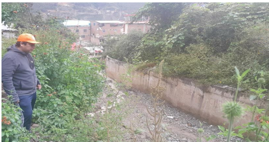
IMAGEN N°02: la quebrada Guadalupe presenta muros de concreto siendo la caja hidraulica la que se encuentra colmatada
